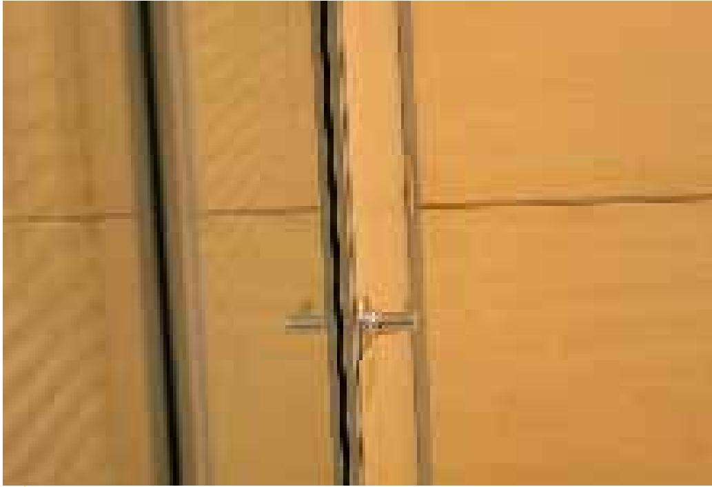
■ Interior del edificio Suministros Medina
